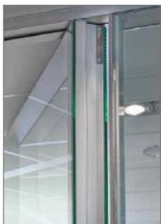
Die Scharniere der lalineia Tuer sind unsichtbar in das Decken- und Bodenprofil aufgenommen.
