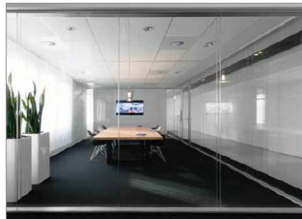
Die minimalistischen Decken- und Bodenprofile laufen konsequent durch.
